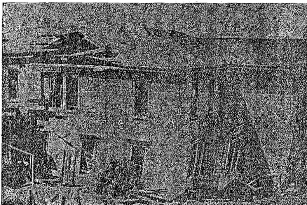
Fig. 24. — Casa cortada en el trayecto de la falla cerca de la estación de Wright
