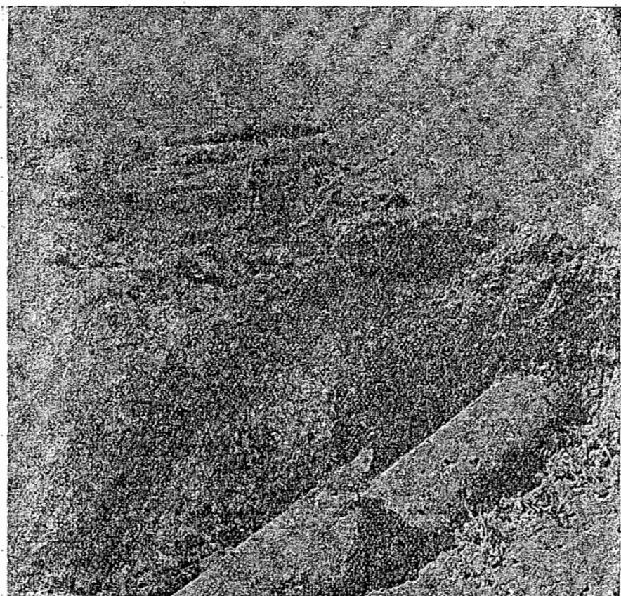
Fig. 20 .—Cañeria telescopiada en la línea de Pilarcitos
