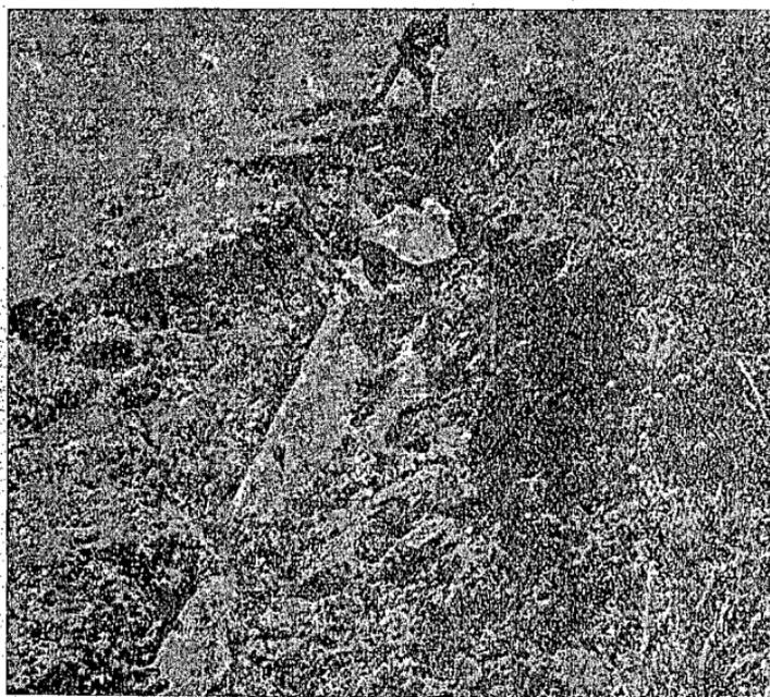
Fig. 21.—Cañería de agua en la línea de Pilarcitos aplastadas sobre el trayecto de la falla
